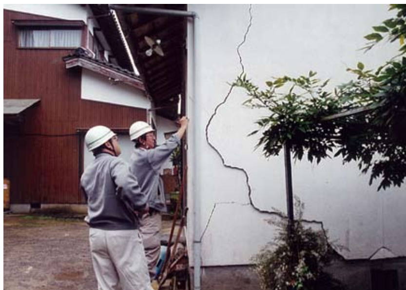
被災建築物応急危険度判定を行う判定士
