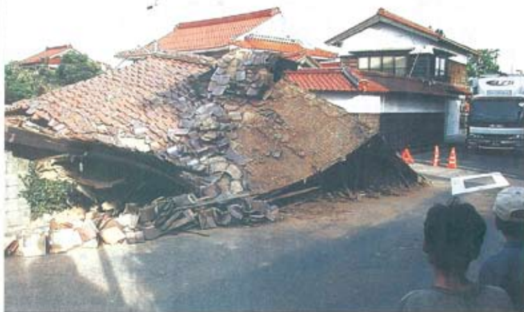
家は半壊も崩れ落ちた民家—6日午後3時すぎ、鳥取県米子市和歌町
