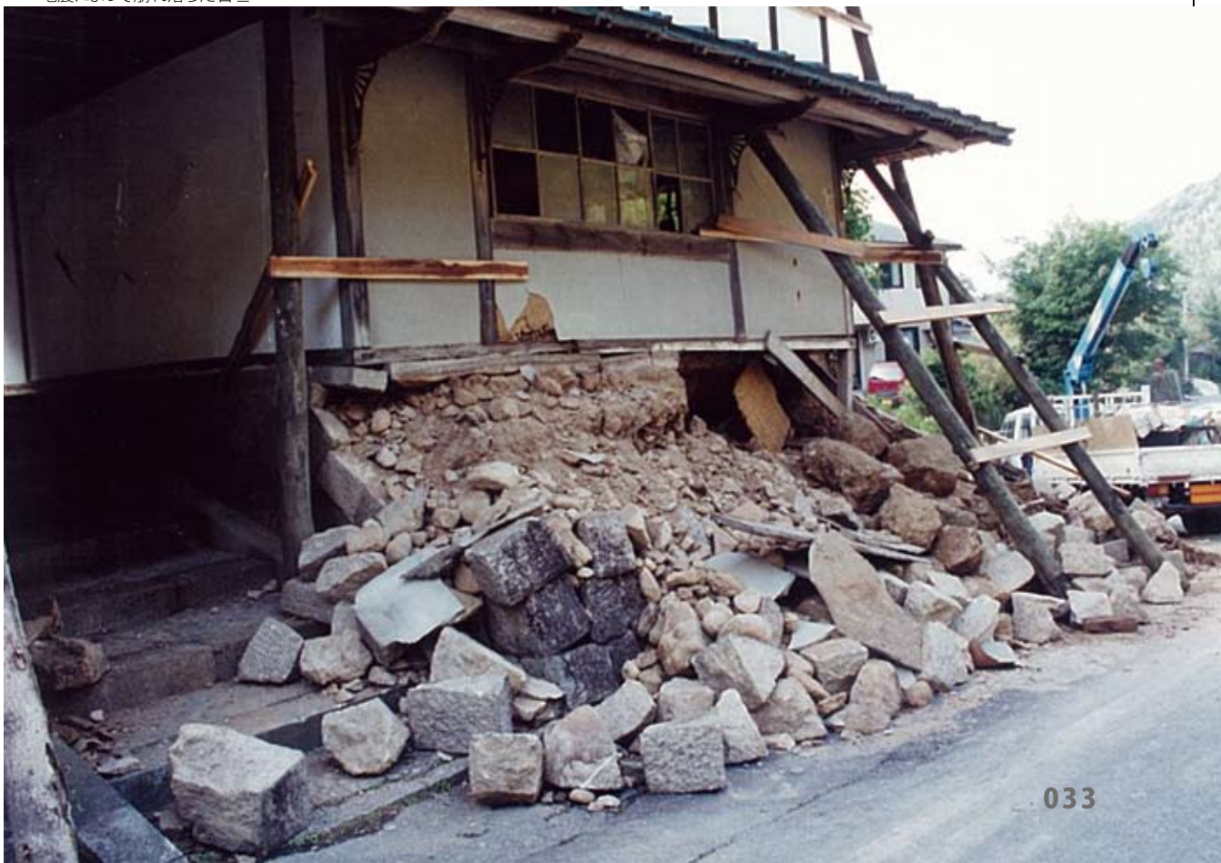
地震によって崩れ落ちた石垣
